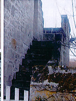
Escalier en pierre sur pignon
