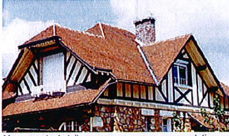
Mouvements de toiture: croupes, noues, ornements sur les rives et les faitages
