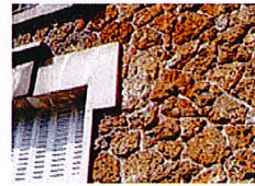
Meulière avec joint creux au mortier bâtard
