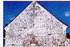
Mur appareillé en pierre, harpes en pierre de taille et remplissage en moellon lié au mortier de chaux
