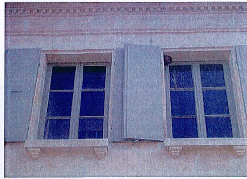
Corniche avec denticules, appuis de fenêtre et feuillure en pierre de taille avec joints à la chaux arasés au nu de la pierre
