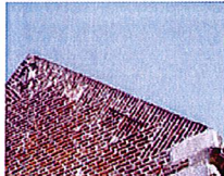
Pignon avec brique en chevron
