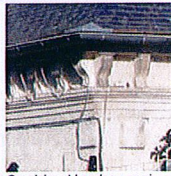
Corniche et bandeau en pierre
