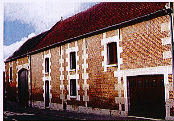
Réutilisation d'une grange en logement
