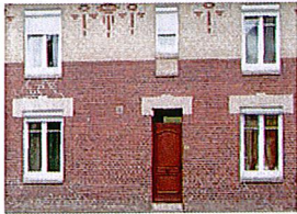
Mur en brique rouge et silico-calcaire
