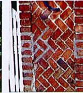
Brique rouge unie, silico-calcaire claire, vernissée et cintrée, badigeonnée en rouge, posée à chevron, formant un escalier ou un couronnement de clôture
