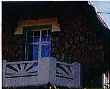
Balcon en béton d'une maison en meulière
