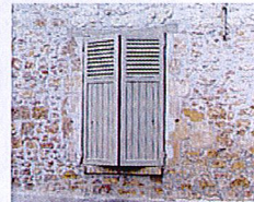
Maçonnerie moellon à pierre vue
