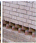
Jeux de brique créant une aération
