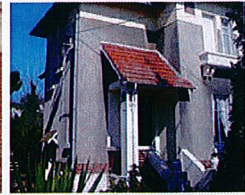
Entrée avec auvent en tuile mécanique
