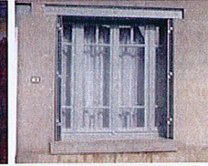
Baie avec linteau et volets métalliques pliants
