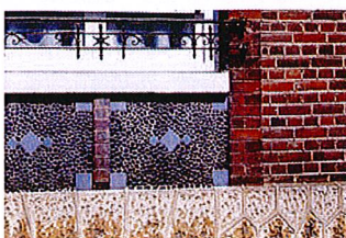
Modénatures : céramiques, bandeaux, corniches, harpes, encadrements
