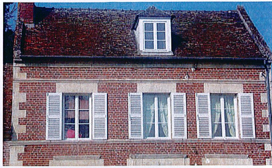
Maçonnerie mixte, volets peints persiennés
