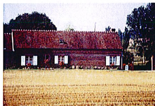
Longère en brique réhabilitée
